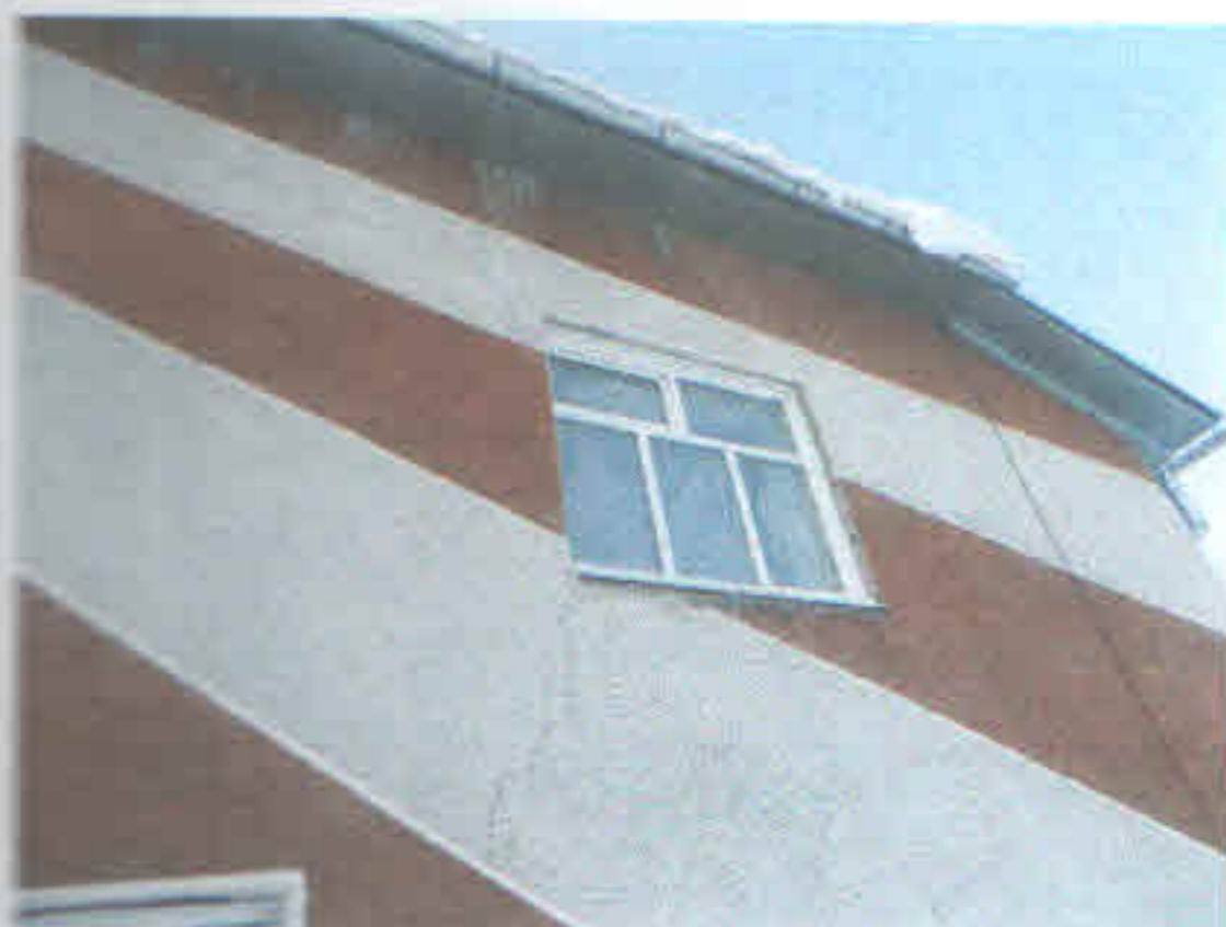
Фасады здания школы на момент обследования Установлено наличие трещин не сквозного характера. Обрушение элементов сливной системы, замачивание и промерзание кирпичной кладки подоконных пространств
