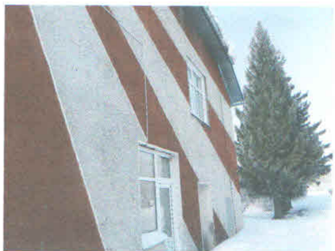
Фасады здания школы на момент обследования Установлено наличие трещин не сквозного характера. Обрушение элементов сливной системы, замачивание и промерзание кирпичной кладки подоконных пространств
