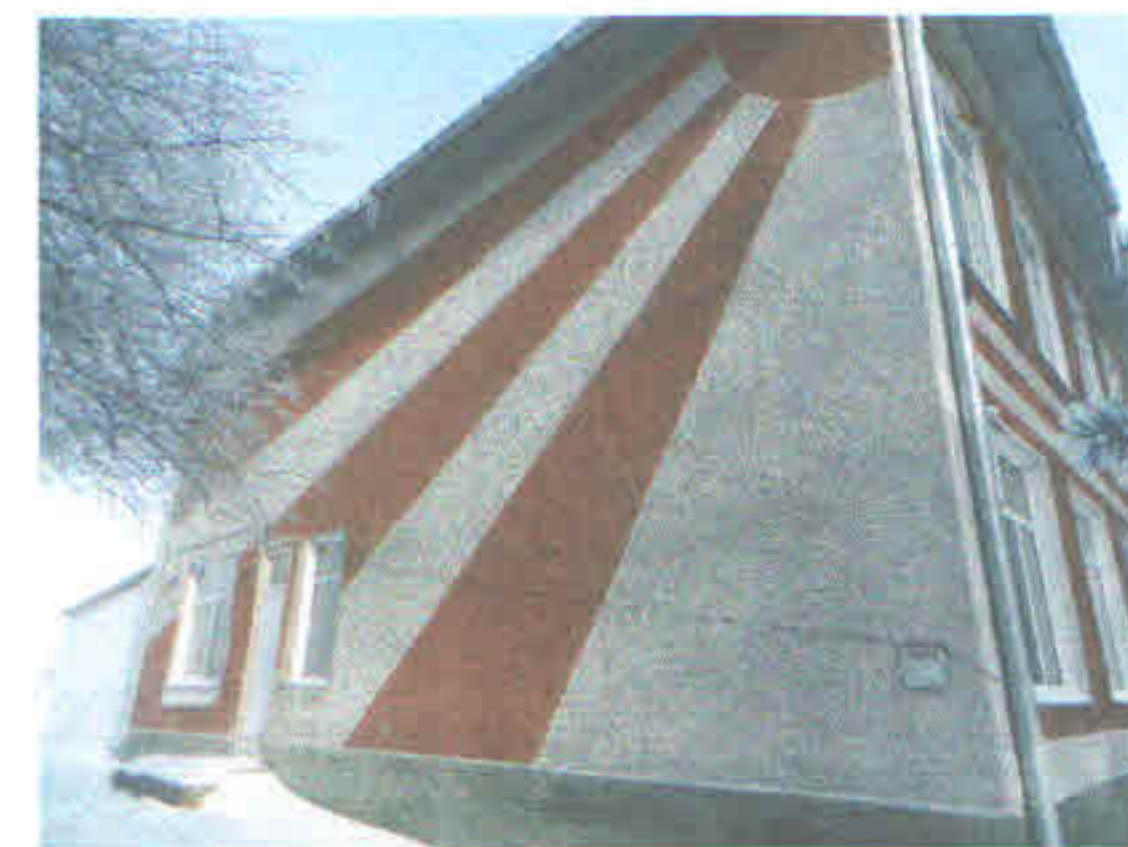
Фасады здания школы на момент обследования Установлено наличие трещин не сквозного характера на материале отделки стен. Обрушение элементов сливной системы, финишной отделки цокольной части стен замачивания и промерзание кирпичной кладки подоконных пространств
