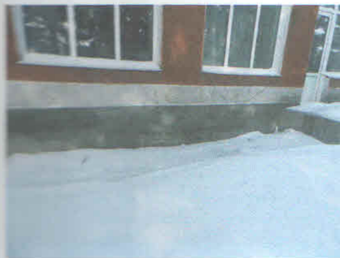
Фасады здания школы на момент обследования Установлено наличие трещин не сквозного характера на материале отделки стен. Обрушение элементов сливной системы, финишной отделки цокольной части стен замачивания и промерзание кирпичной кладки подоконных пространств
